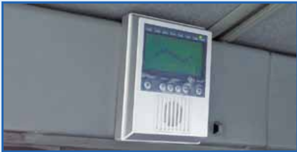
貨物室セキュリティ主装置（セット・解除用のカードリーダー内蔵）
